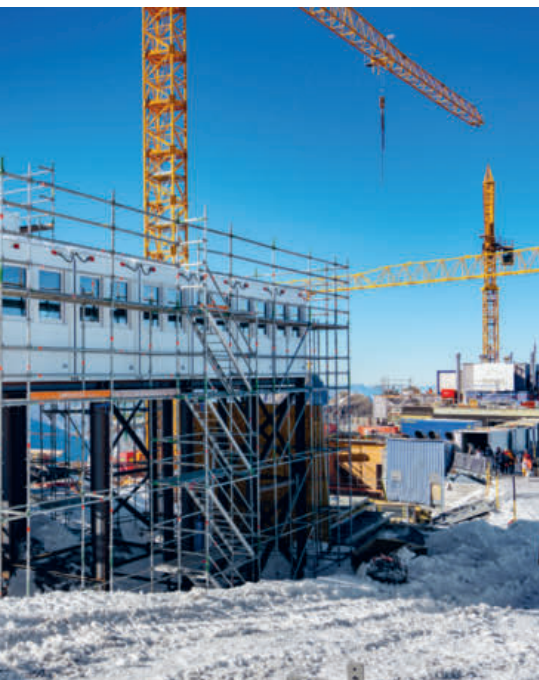
Hier entsteht das Containerdorf für Pistenrettung, Kiosk und Aufenthaltsräume.
