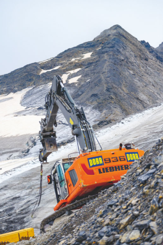
Schergewicht im Grosseinsatz – der auf der Titlis-Baustelle eingesetzte Raupenbagger wiegt 40 Tonnen.
