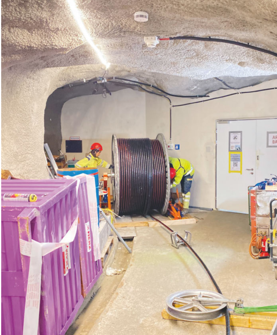
Im August 2024 zogen Mitarbeitende des EWN die Stromkabel in den Infrastrukturkanal ein. Damit ist der Titlis unterirdisch mit Strom erschlossen. Mittlerweile fließt auch Wasser.
