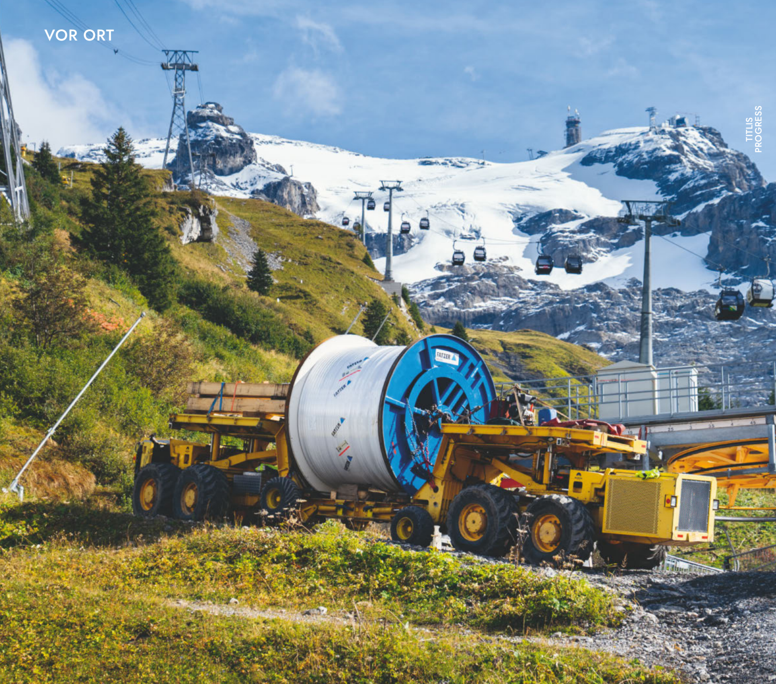
Hohe Schule des Seiltransports – allein ein Tragseil wiegt beeindruckende 37 Tonnen.
