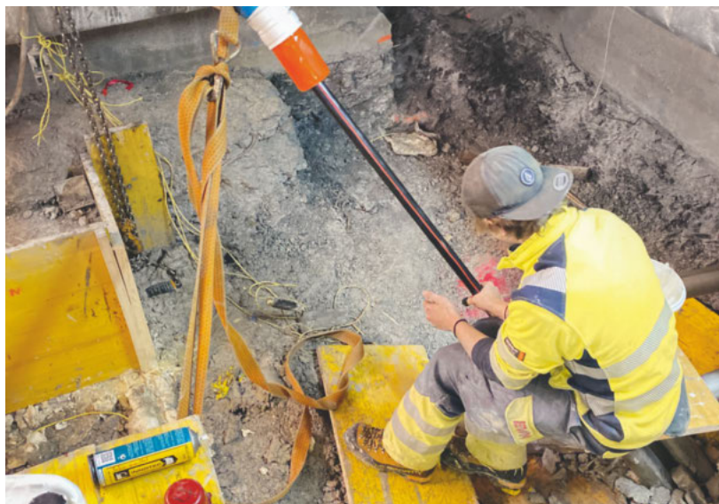
Eines der drei Stromkabel verschwindet im Bohrloch.
